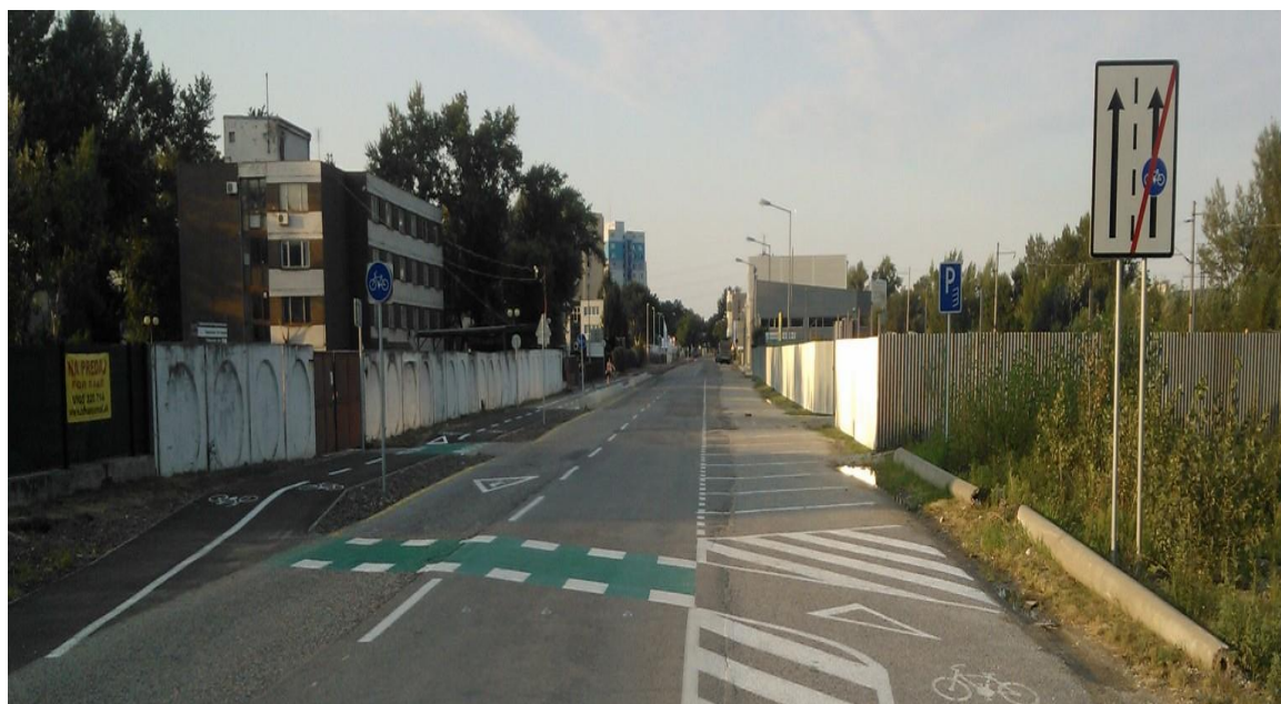
Obrázok 19 Realizácia kríženia cyklistického pruhu s PK (Bratislava)
