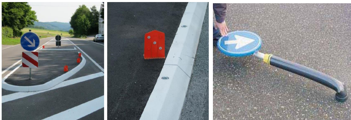
Obrázok 3.7 - Pojazdne ostrovčeky s nájazdovými obrubníkmi a použitím ohybných cestných prvkov
