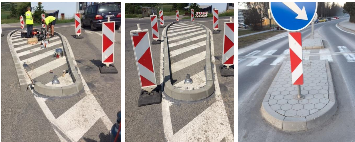
Obrázok 4.10 - Vytvorenie ostrovčeka pomocou lepených prvkov bez zásahu do konštrukcie vozovky
