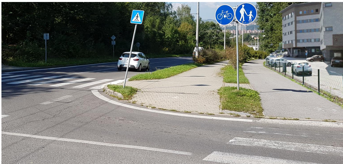
Obrázok 3.9 - Deliace ostrovčeky s trávnikom a krovím vysadeným až za priechodom pre chodcov
