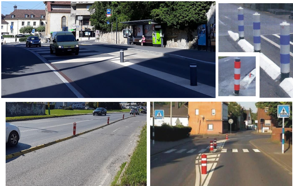
Obrázok 4.22 - Oddelenie jazdných pruhov pomocou stĺpikov a vodiacich prahov s doskami
