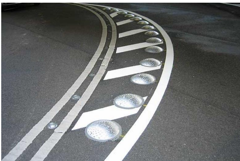
Obrázok 4.11 - Vytvorenie ostrovčeka pomocou lepených kovových prvkov
