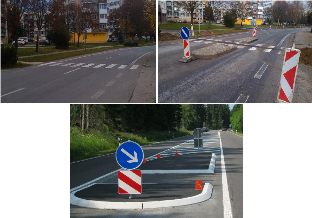
Obrázok 3.3 - Vloženie stredového ostrovčeka na prietahu
