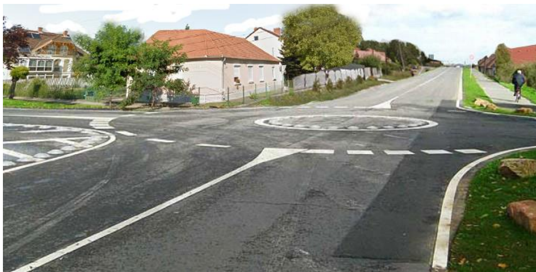
Obrázok 4.16 - Použitie lepených kovových prvkov (tanierov) na vytvorenie malej okružnej križovatky
