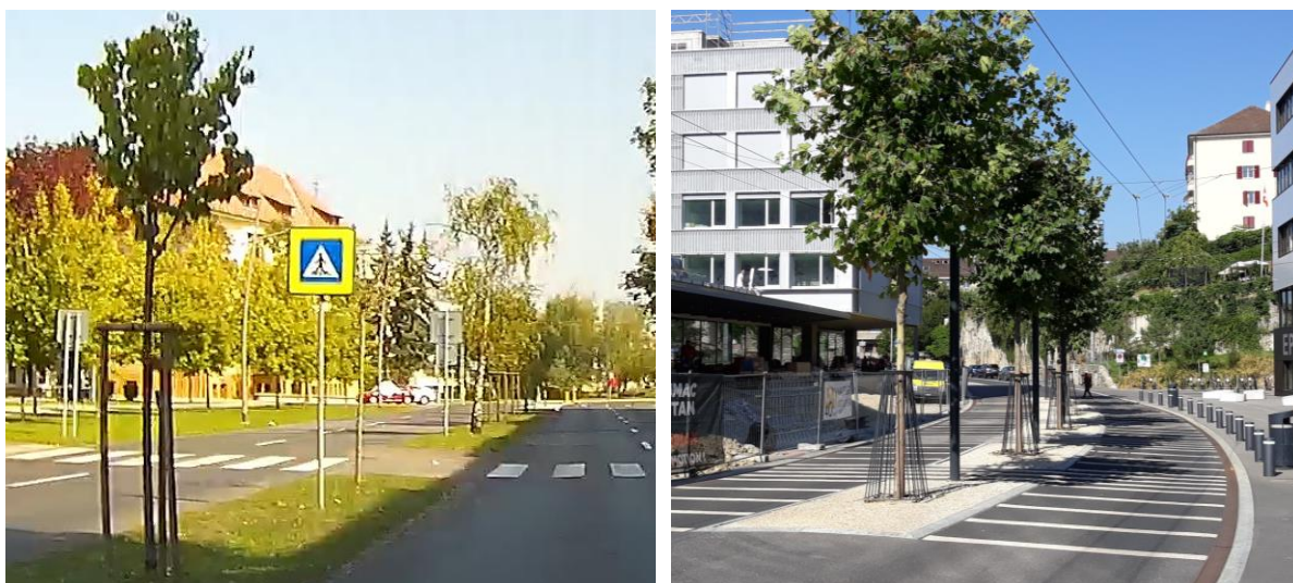
Obrázok 4.5 - Stredný deliaci pás nespevnený, zatrávnený alebo s riečnym štrkom a výsadbou aleje
