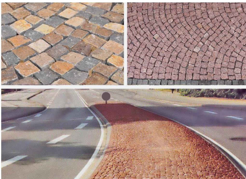
Obrázok 4.6 - Spevnený stredný deliaci pás farebnou kamennou dlažbou
