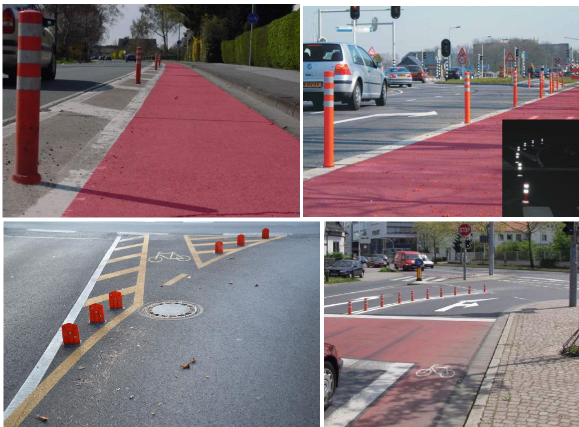
Obrázok. 3.6 - Oddelenie pruhov s prvkami pre upokojuvanie dopravy
