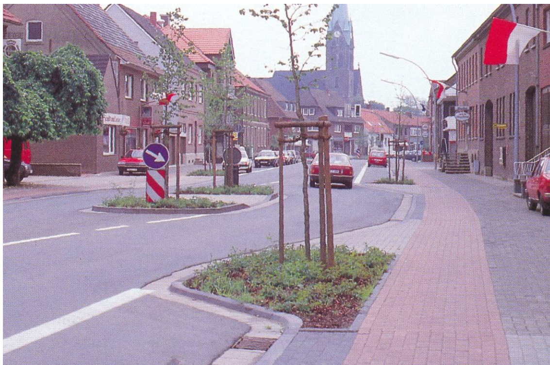
Obr. 7.39 Dlhý priečny prah s posunom jazdného pruhu
