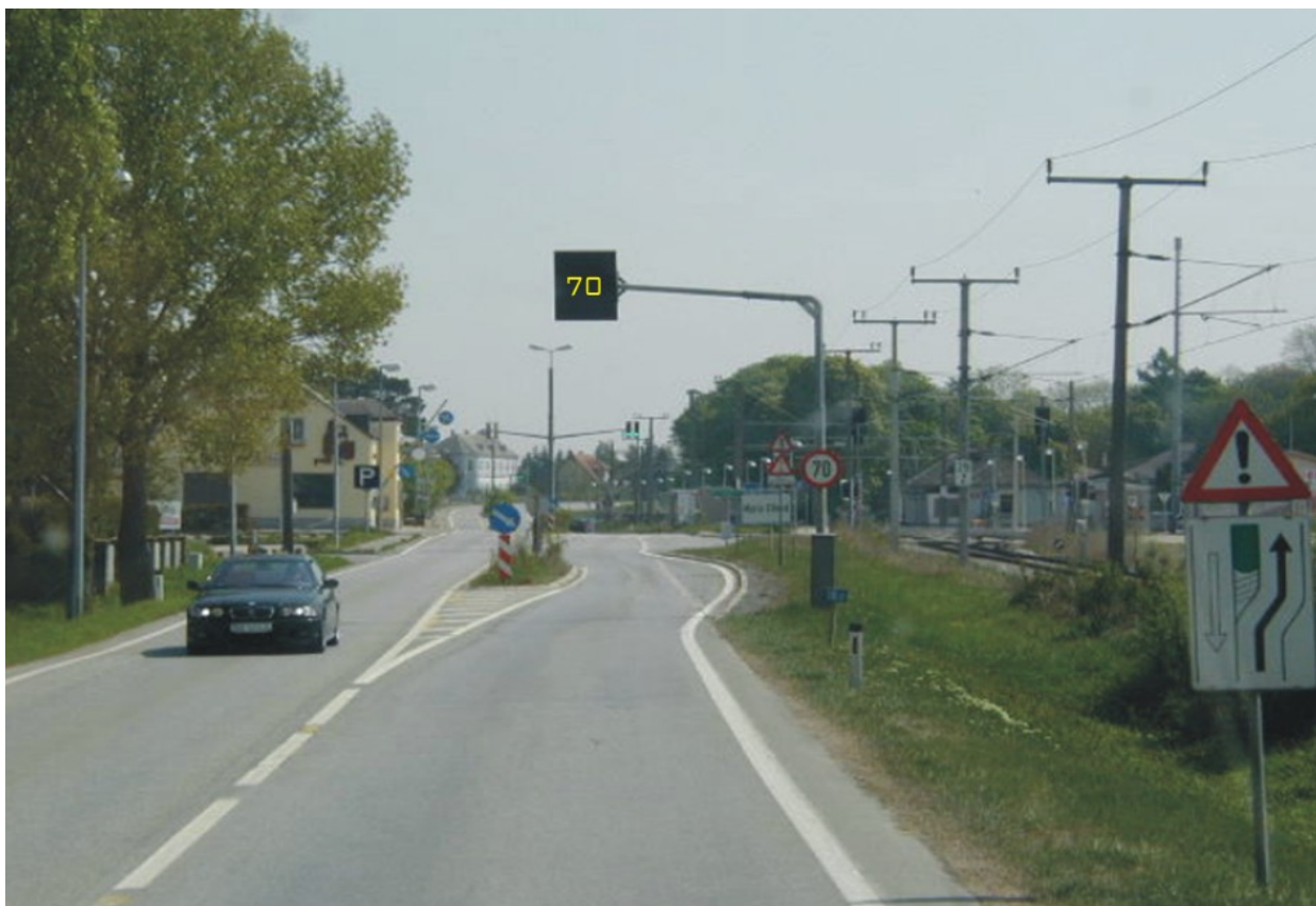
Obr. 7.25 Varovná signalizácia v kombinácii s posunom jazdného pruhu
