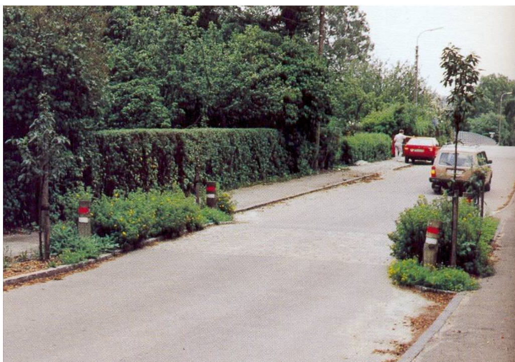
Obr. 7.40 Zúženie vozovky na jeden pruh
