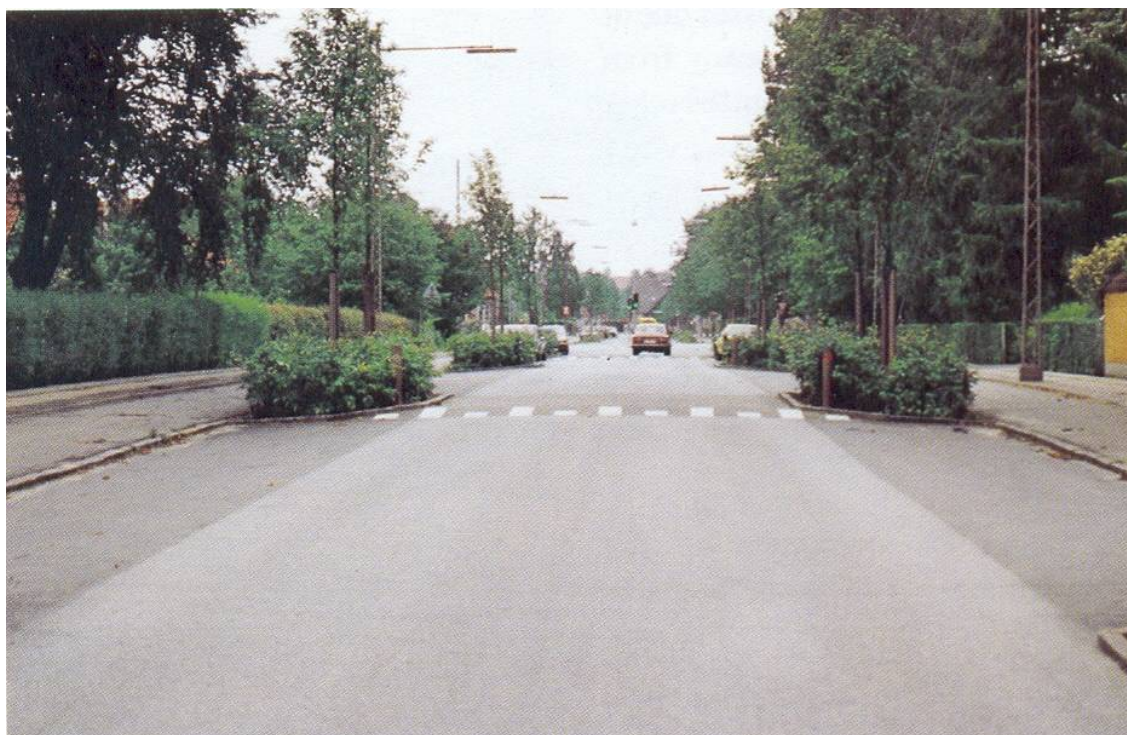
Obr 7.34 Posun a zúženie jazdného pruhu vysunutou plochou
