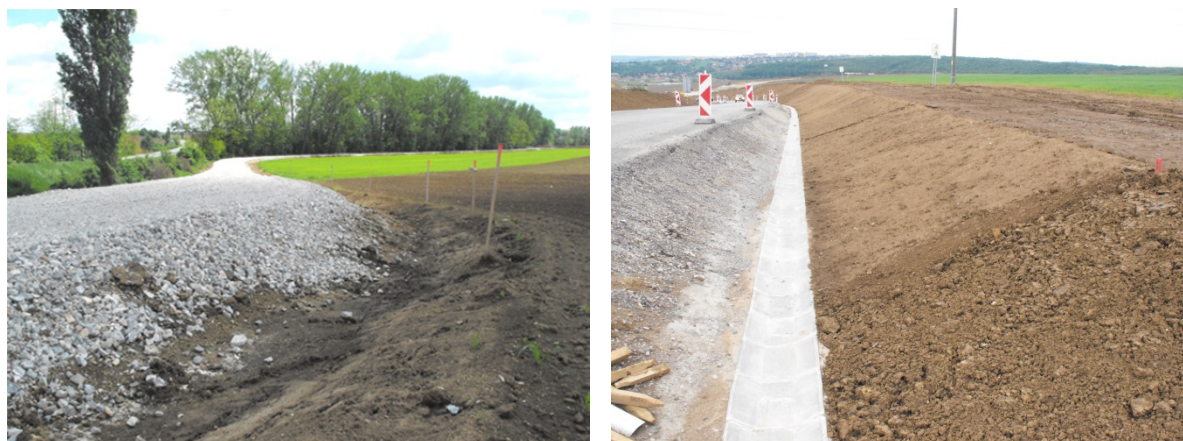
Obr. 6.19 Cestné priekopy (pozdĺžne odvodnenie) (foto: Konc, L.)
