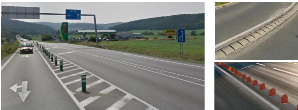
Obrázok 44 – Príklady zvýraznenia oddelenia a smerovania dopravných prúdov na úrovňovej križovatke
