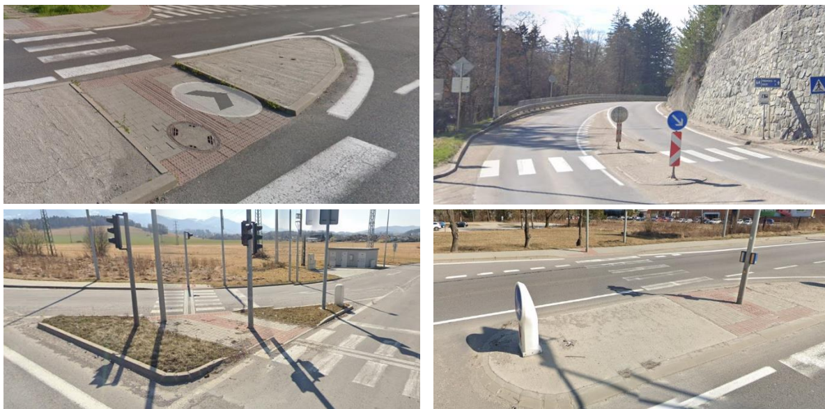
Obrázok 61 – Príklady dopravných ostrovčekov s ochrannou funkciou (Zdroj: https://www.google.com/maps )
